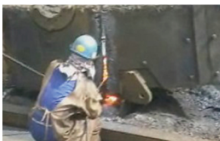
3. 大型プラント熔断解体作業
